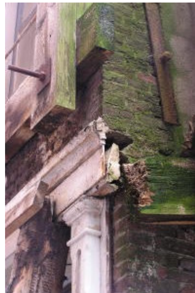
Voorbeeld 6b: Dirk van Hasseltsteeg 3, detail van de puibalk
